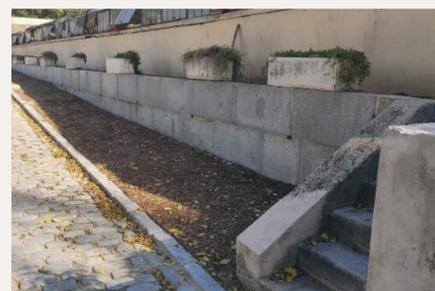
Vivero de Estufas: plataforma sobre muros de construcción de piedra realizada por los canteros municipales en la zona de las estufas 2, 3 y 4.
